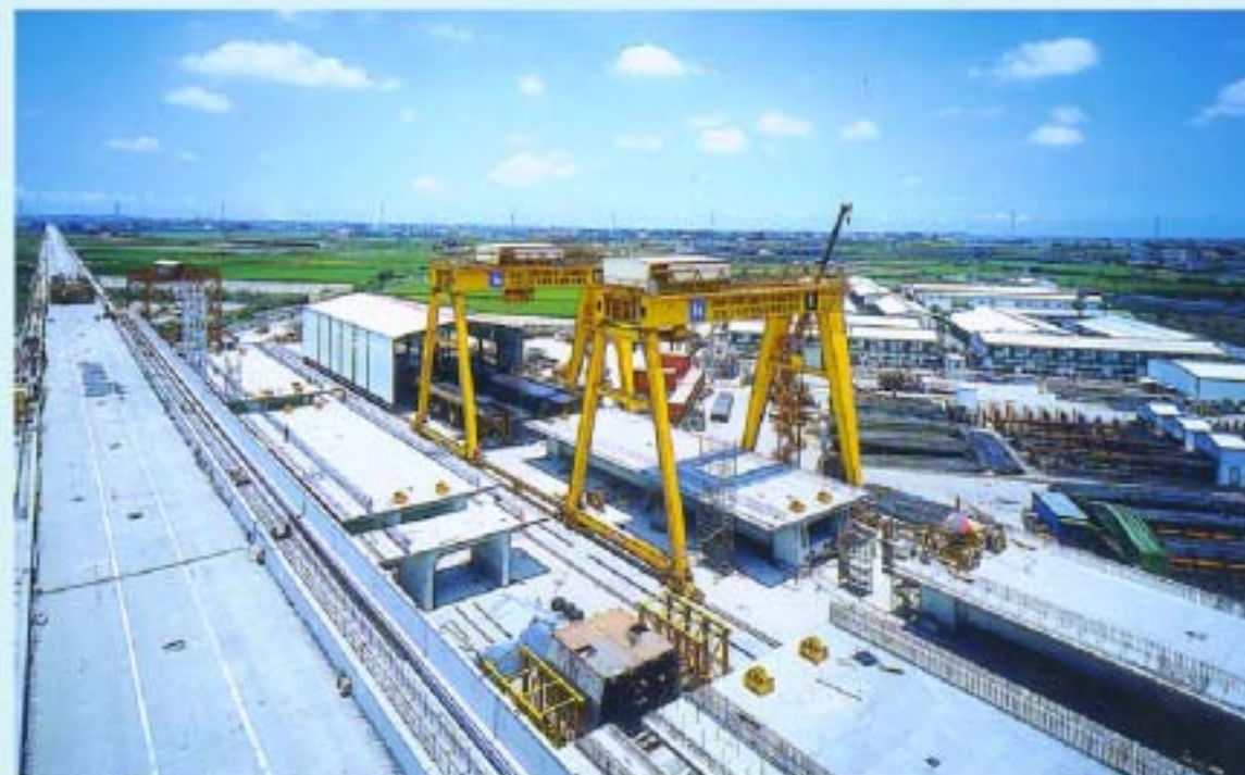
▲ C270 Pre-casting yard C270 標預鑄場
