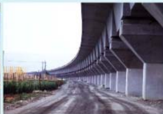
▲ Standard bridge construction 完成吊裝的部份路段
